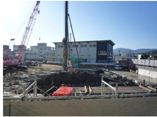
【新体育館と校舎改築工事現場】
