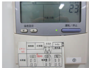
職員室にたくさんあるエアコンスイッチには区画を表示し, 必要なエアコンだけスイッチON
